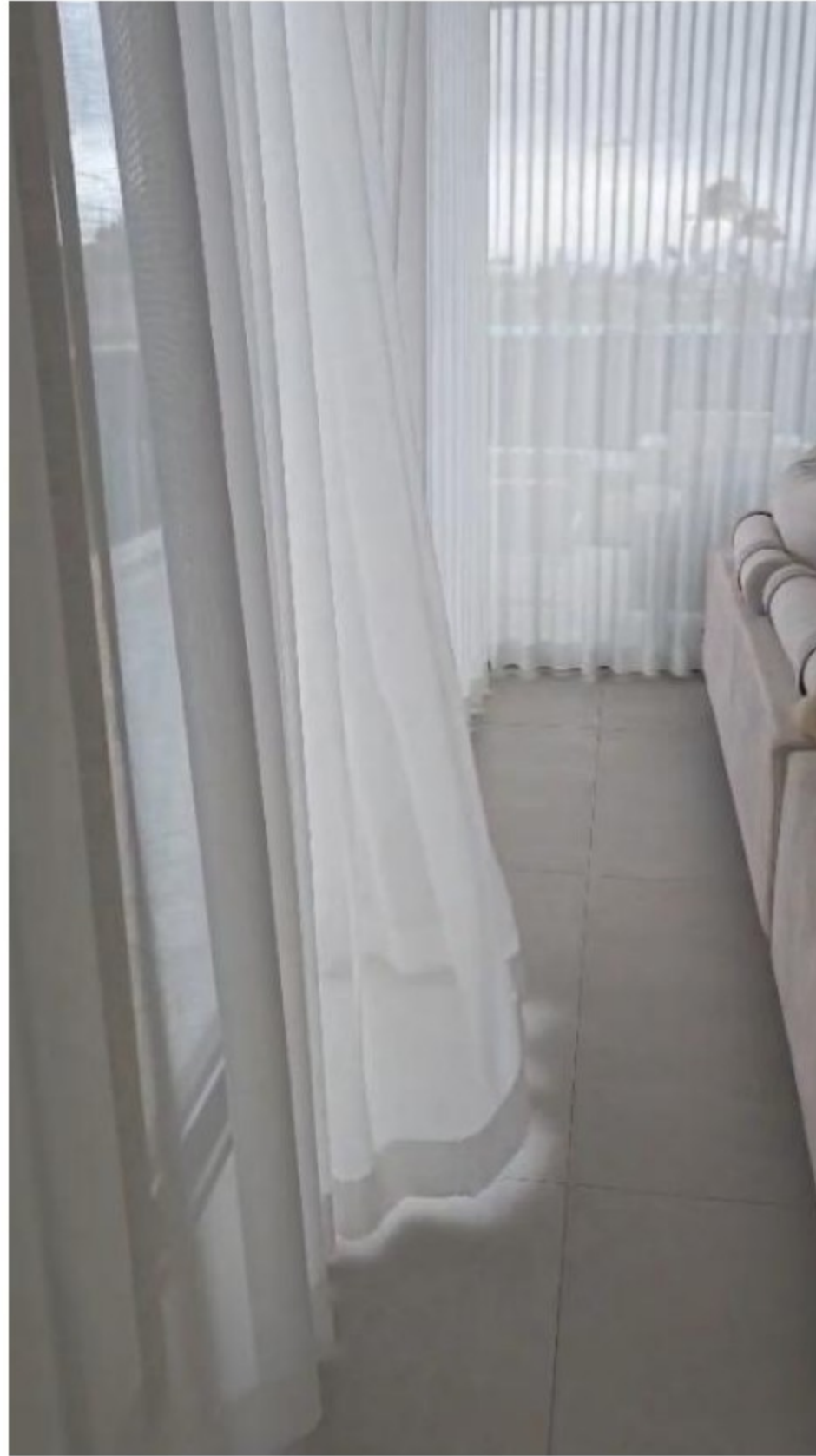
Foto 02 Movimiento de elementos textiles interiores por infiltración de aire con carpintería cerrada.
