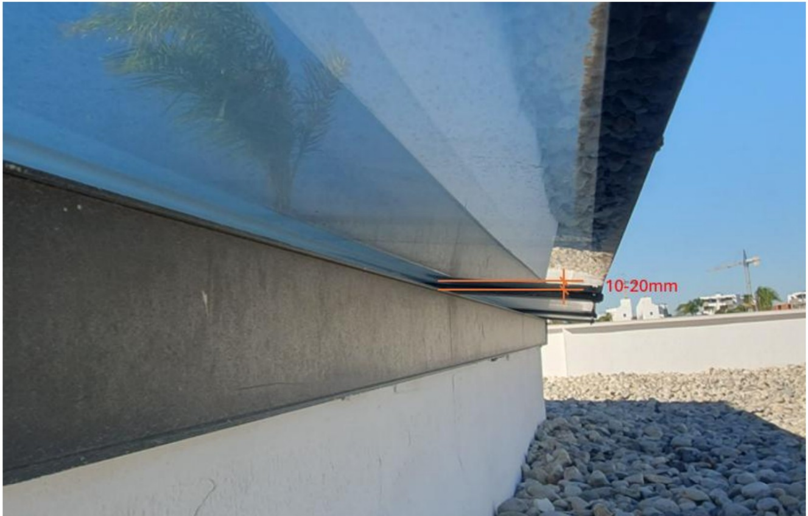
Foto 09 Detalle inferior del lucernario con abertura lineal ( \approx 10-20 mm)
