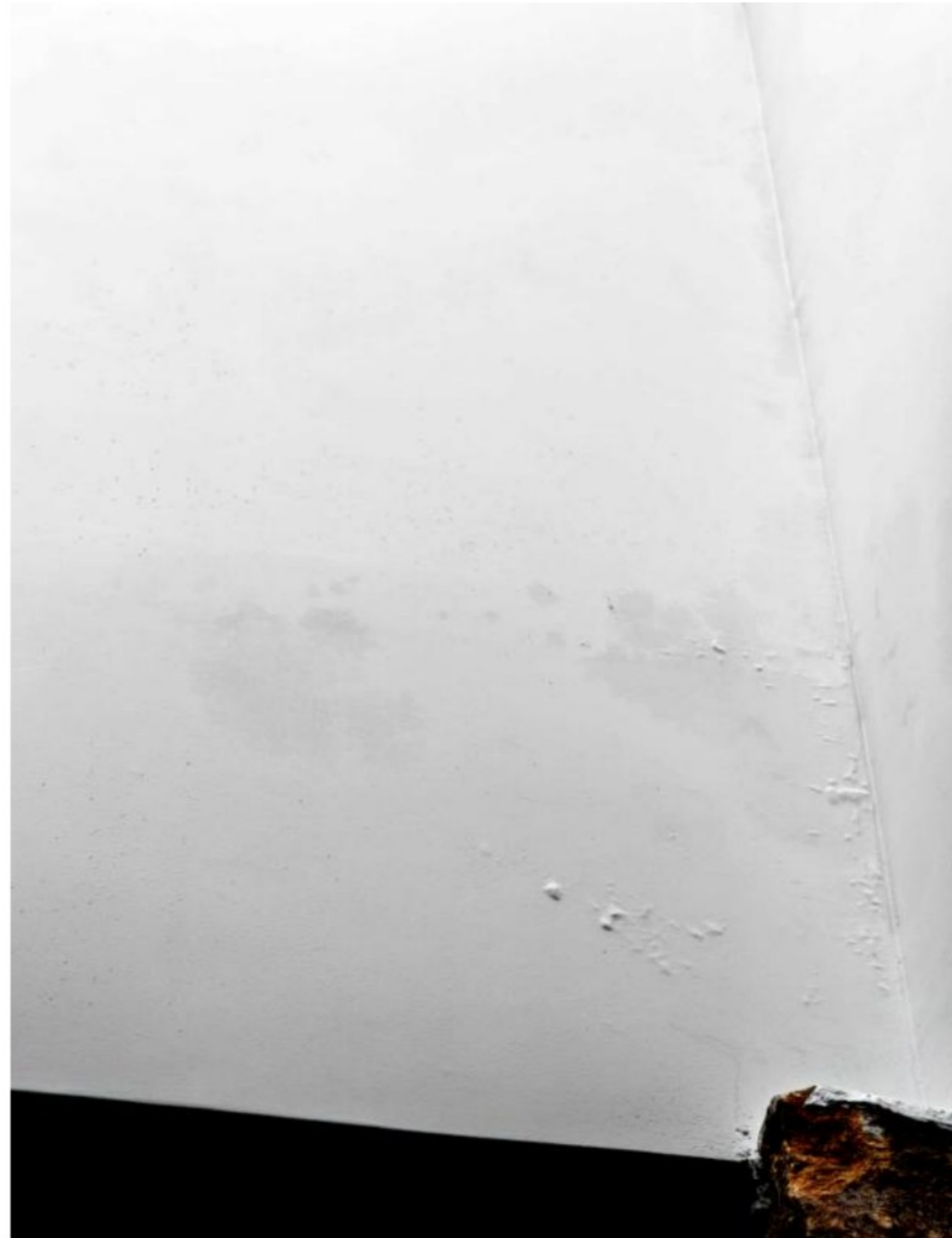
Foto 10 Detalle inferior del lucernario con abertura lineal (≈10–20 mm)
