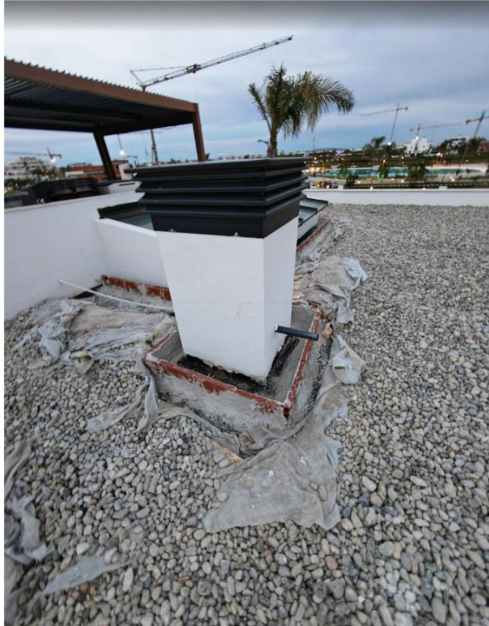
Foto 12 Pruebas de estanqueidad, Lámina polimérica de impermeabilización
