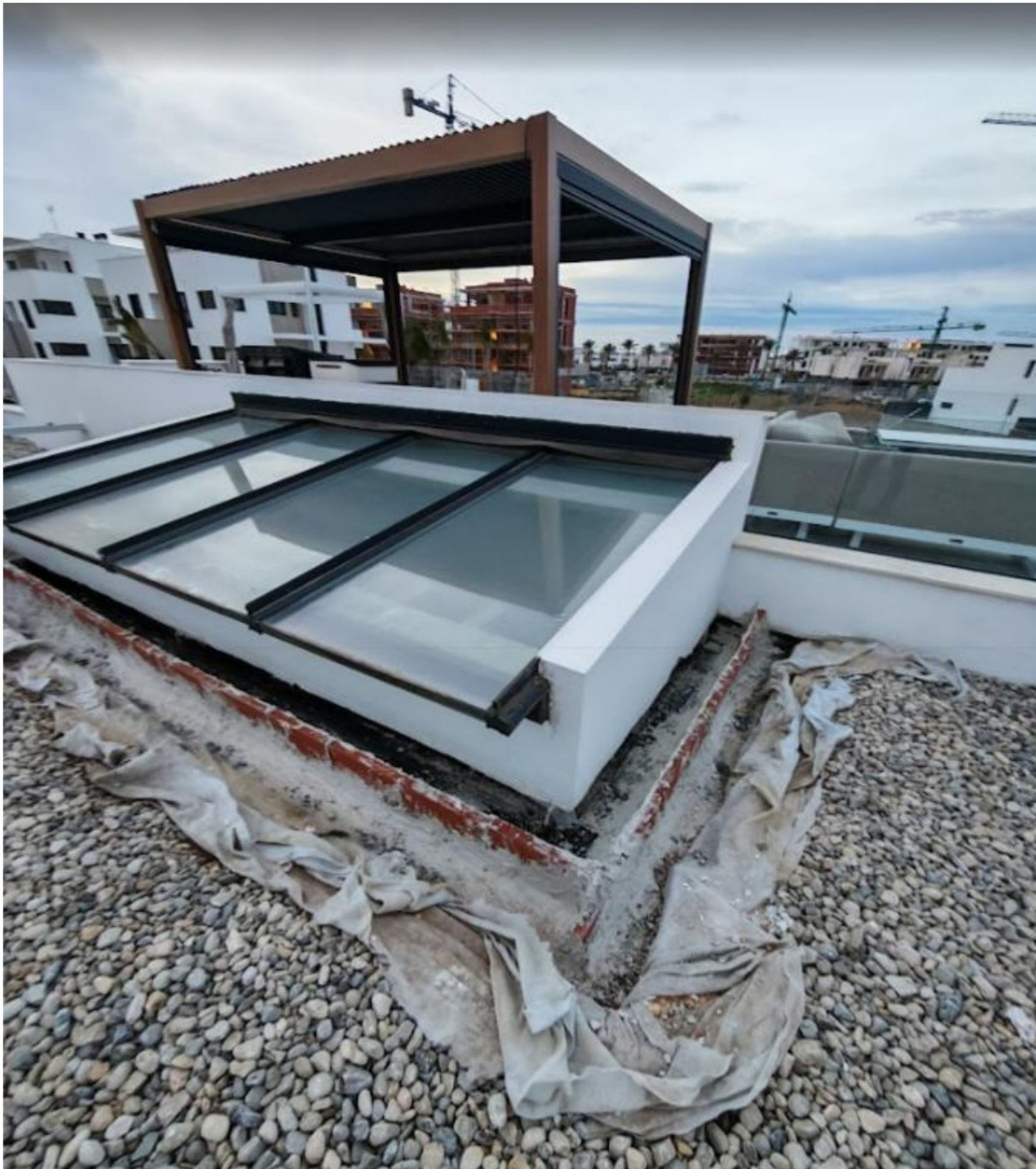
Foto 15 Comprobacion estanqueidad lucernario, 3/4.2.2026
