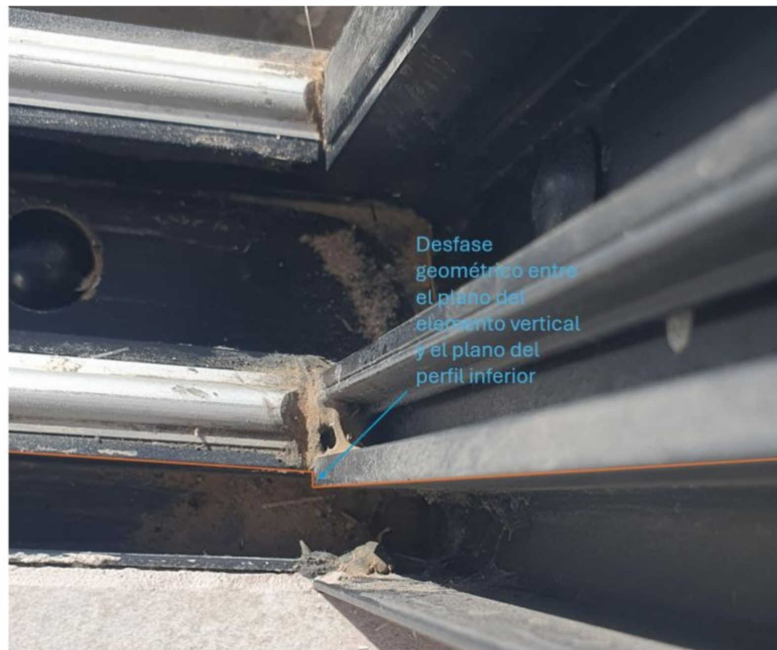
Foto 03 Marco Carpintería corredera desfasada
